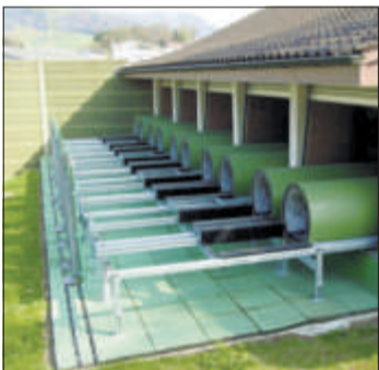
So sehen die lärm-dämmenden Schiessstunnel aus. BILD PD
